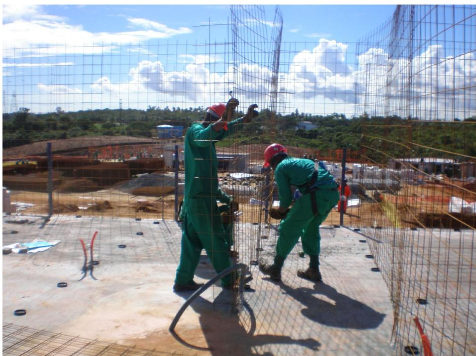
**Figura 14 – Armação das paredes. Fonte: autoria própria**
