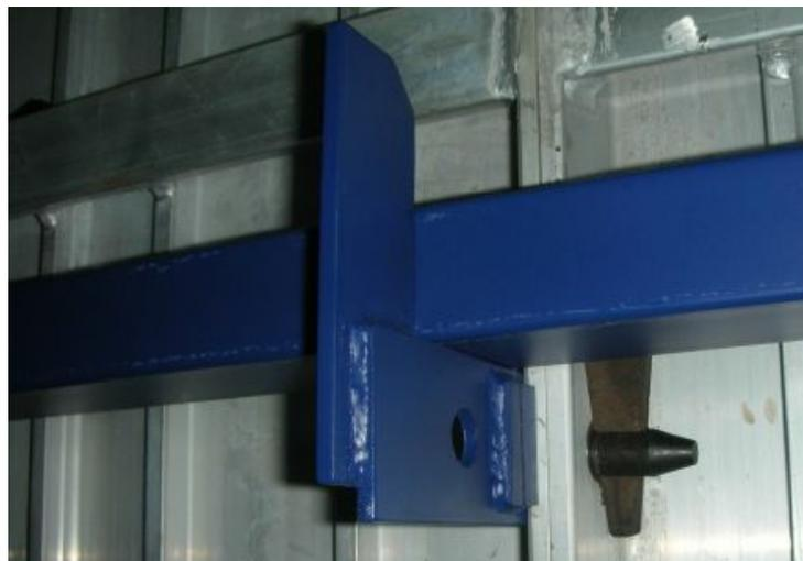
**Figura 08 – Alinhadores de parede. Fonte: Aluma Systems**
