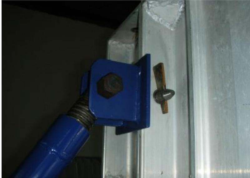
**Figura 09 – Escora de parede. Fonte: Aluma Systems**
