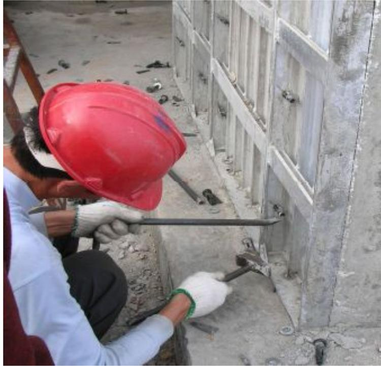
**Figura 05 – Desforma com auxílio de martelo e pé-de-cabra.
