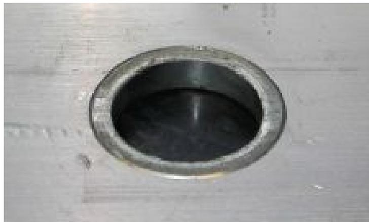
**Figura 03 – Reforço do furo dos painéis. Fonte: Aluma Systems**
