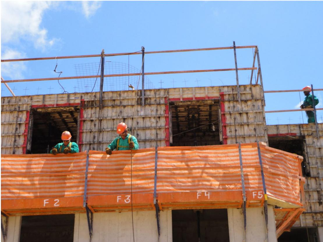
**Figura 11 – Equipamentos de proteção coletiva. Fonte: autoria própria**
