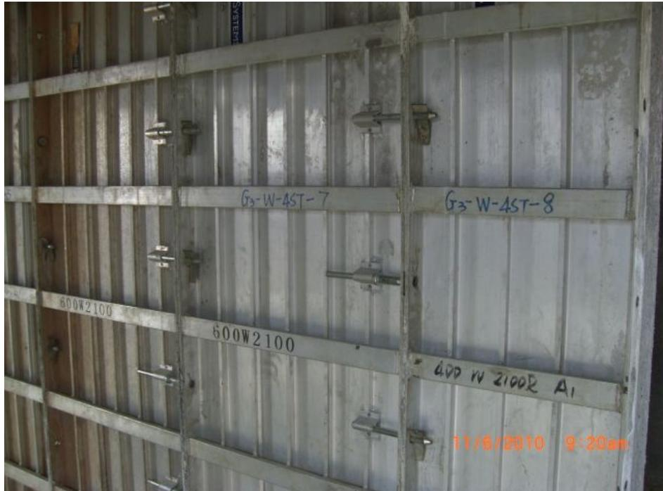
**Figura 16 – Painéis da fôrma montados. Fonte: autoria própria**
