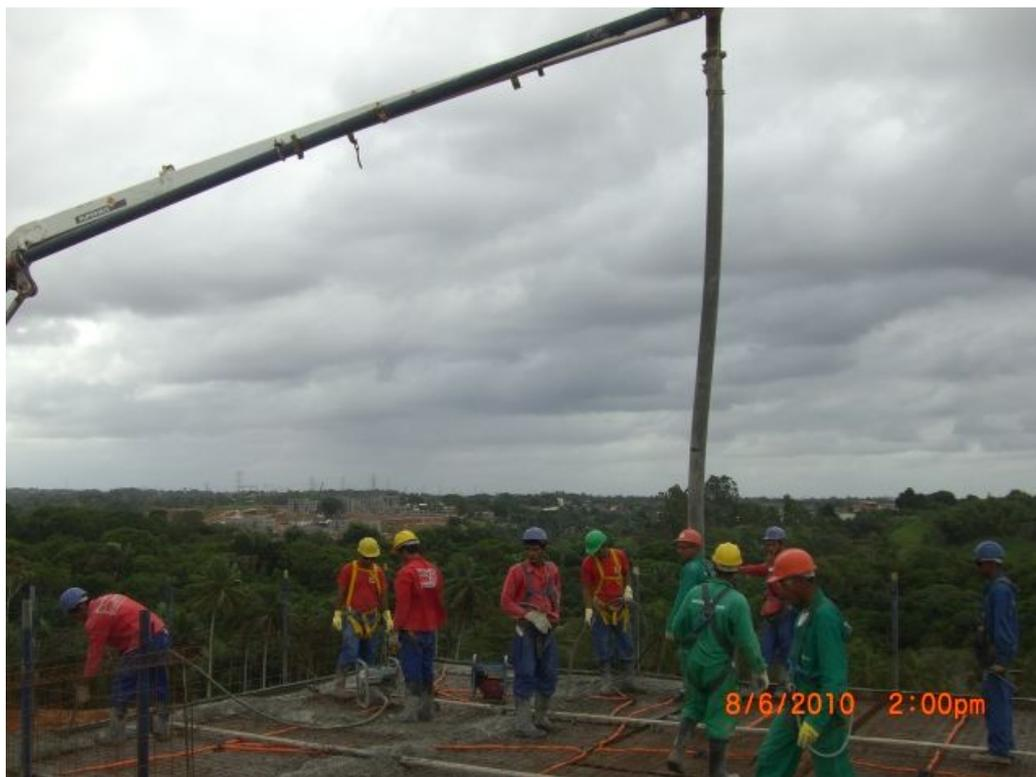
**Figura 19 – Concretagem. Fonte: autoria própria**
