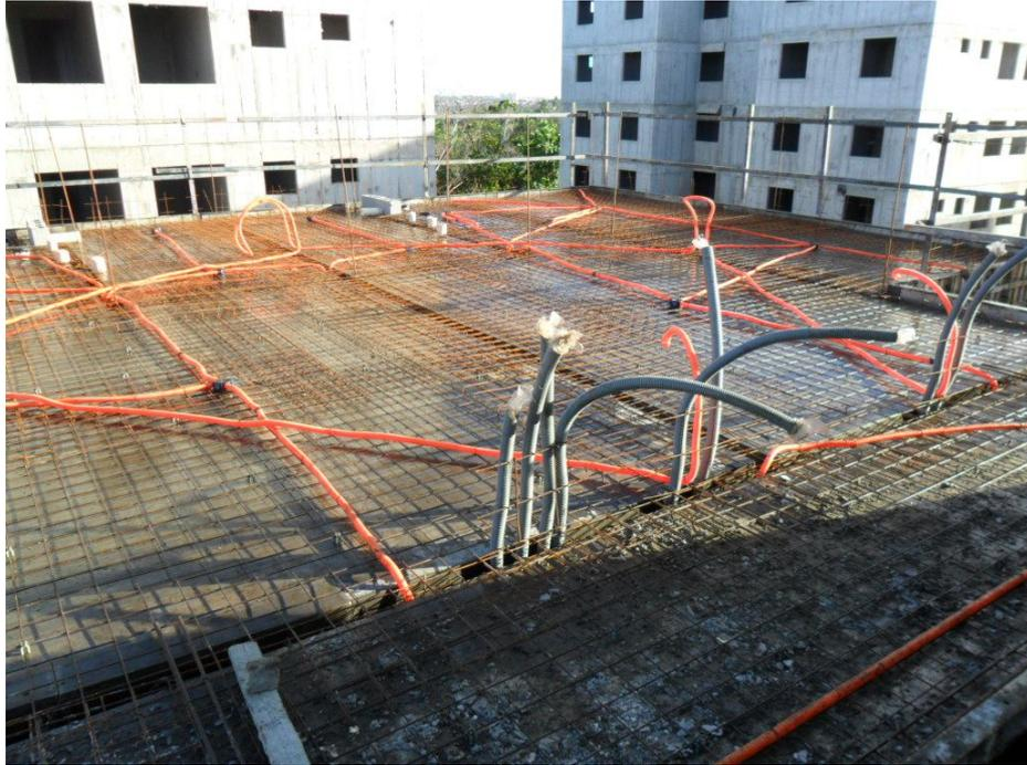
**Figura 18 – Laje antes da concretagem. Fonte: autoria própria**
