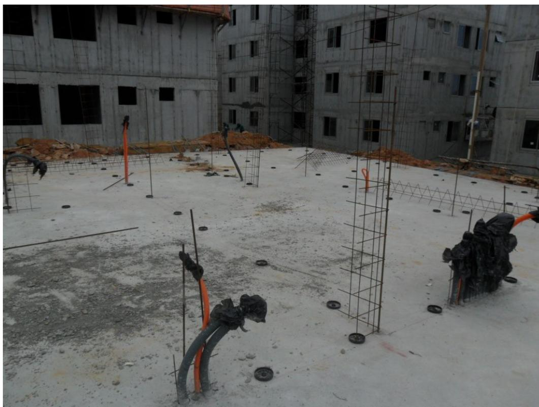
**Figura 13 – Fundação com arranques e alinhadores. Fonte: Autoria própria**
